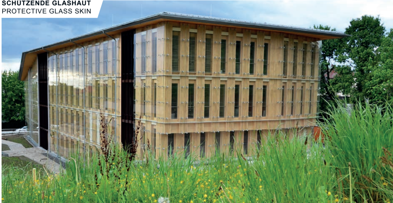
Haus der Bauern, Freiburg, Deutschland ** Farmers' House, Freiburg, Germany
